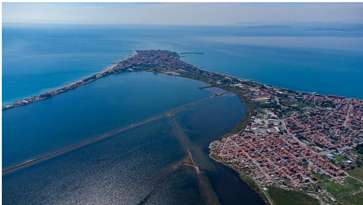
Фиг. 17 Строителство, променящо естествения характер на бреговата ивица
